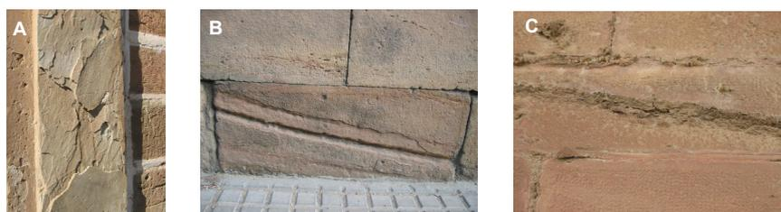
Figura 1: A: desplazados; B: acanaladuras; C: extrusión de arcillas.
