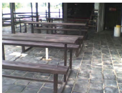
fig 5. un ejemplo de producto a partir de basaltos naturales fundidos y recristalizados, que tienen aplicación como pavimentos rústicos o industriales de elevada resistencia a la abrasión.
