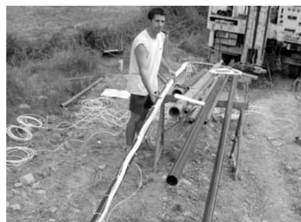
fig 1. Sistema de toma de muestra multinivel
